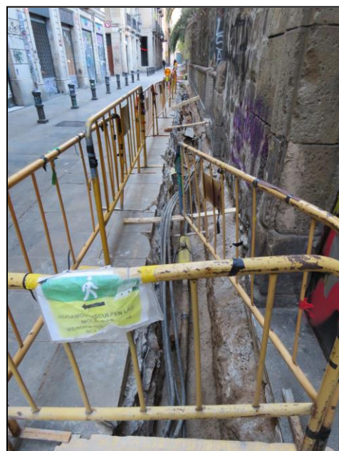
Vista general del Tram 1 i el Tram 2 obert de la Rasa 1 i detall dels serveis existents
